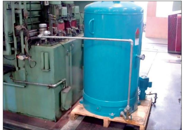
CJC® Feinfilteranlage 427/108 installiert an einem IPSEN Kammerofen
