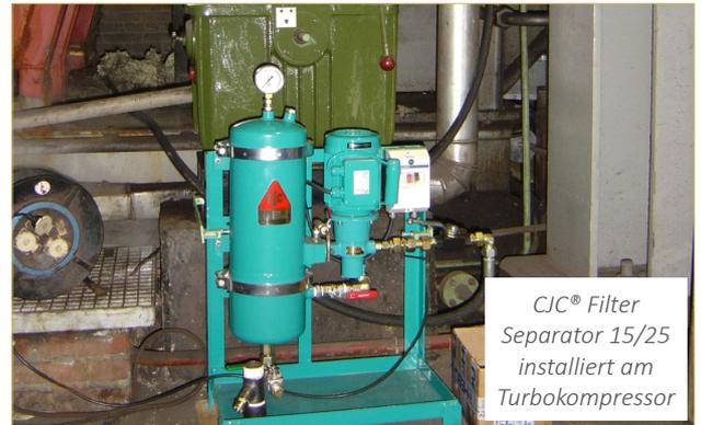
CJC® Filter Separator 15/25 installiert am Turbokompressor
