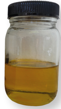
Ölprobe Transformator #8 mit CJC® Ölpflegesystem nach 5 Monaten
