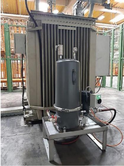
**Bild 3:** ES 2000 Filteranlage
