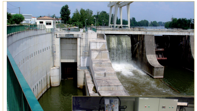
EDF Wasserkraft-Talsperre, Frankreich
