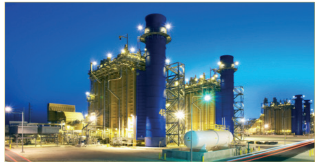
Hauptkraftwerk, Florida, USA
