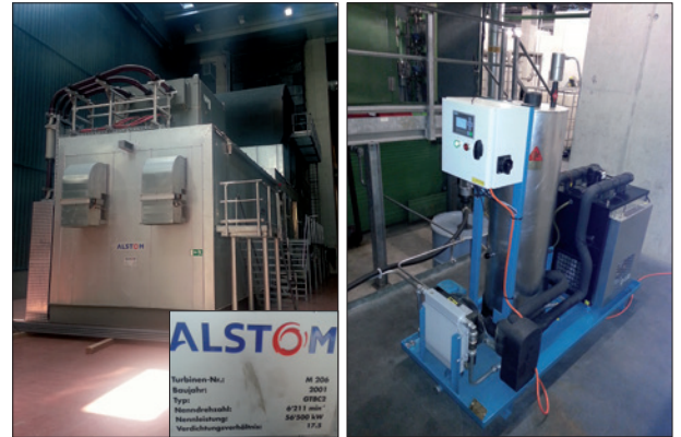
CJC® Varnish Removal Unit 27/108 installiert an einer ALSTOM Gasturbine Typ GT8C2
