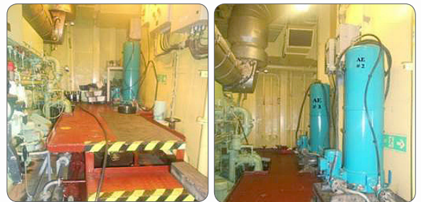
Installierte CJC™ Ölpflegesysteme 27/108
