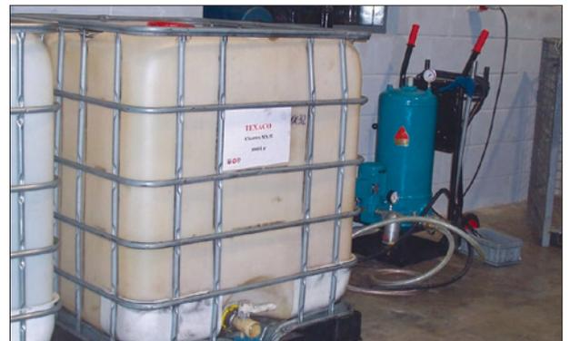
CJC® Feinfilteranlage angeschlossen am 1.000 Liter Setz- und Sammeltank
