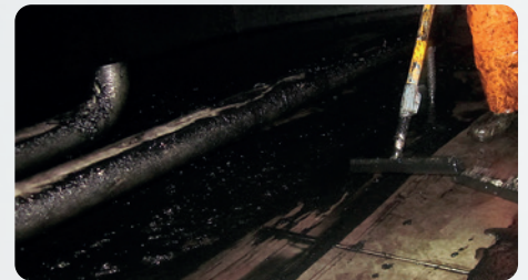
Tankreinigung aufgrund von Dieselpest
