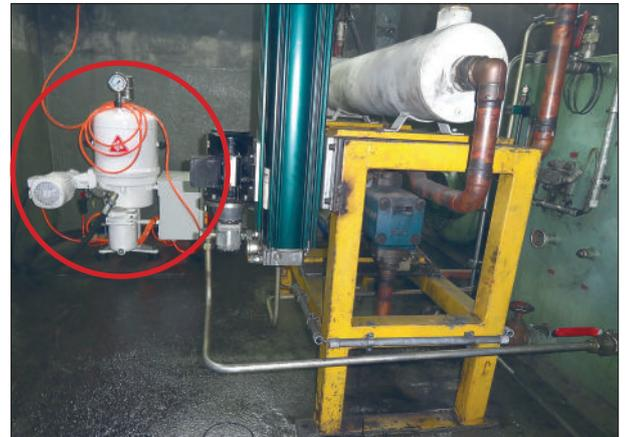
CJC® Filter Separator 27/27 installiert an dem Hydraulikaggregat der BANNING Ringwalzmaschine
