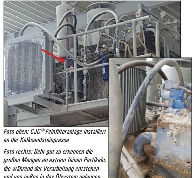
Foto oben: CJC® Feinfilteranlage installiert an der Kalksandsteinpresse
