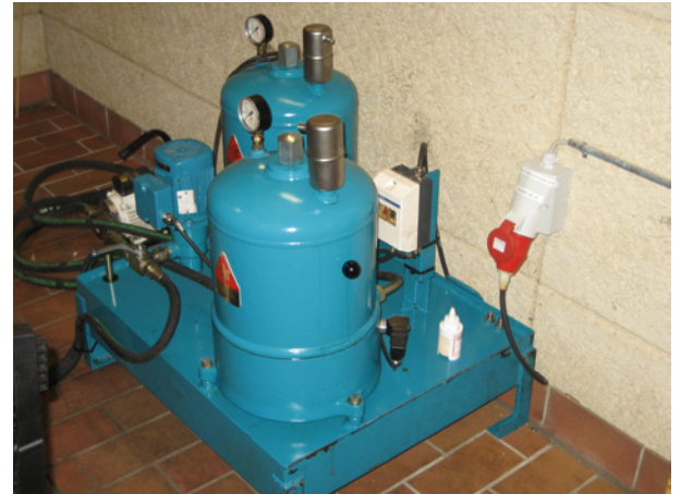
CJC® Schmierölfilter installiert an einem MAN Gasmotor bei E.ON Danmark A/S
