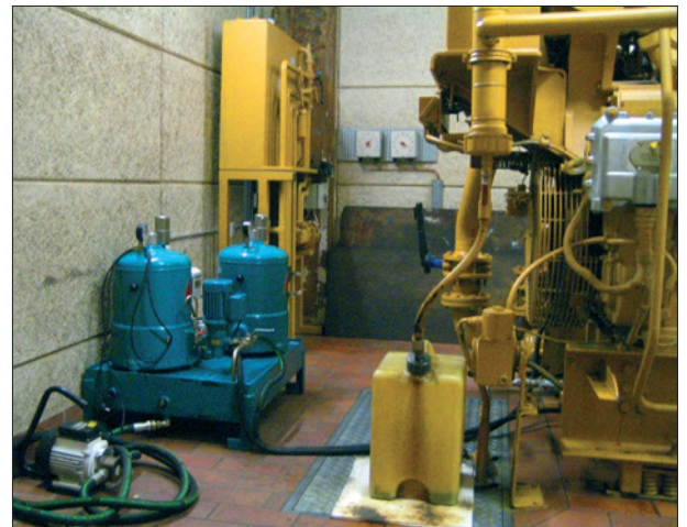
CJC® Schmierölfilter installiert an einem CATERPILLAR Gasmotor bei E.ON Danmark A/S
