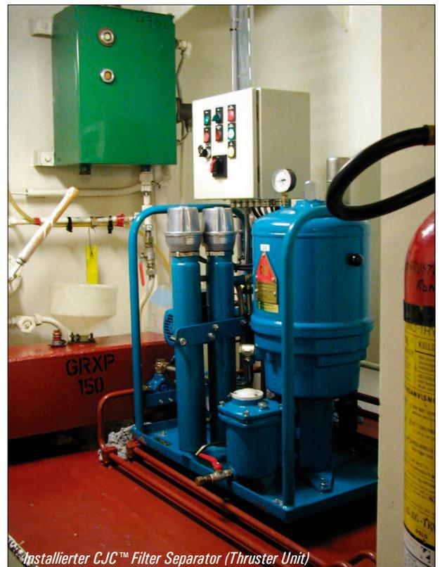
Installierter CJC™ Filter Separator (Thruster Unit)
