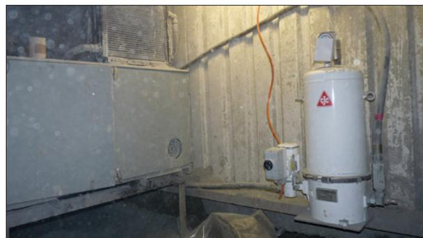
CJC® Feinfilteranlage installiert am Schmieröltank des Kegelbrechers.
