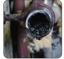
Abb. 40 Ablagerungen im Leitungssystem
