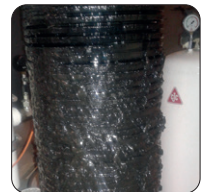
Abb. 41: Gesättigter Thermalöl-Filter, der Verunreinigungen aus dem Öl entfernt bevor sie sich ablagern. Zusätzlich sorgt er für eine langanhaltend stabile Conradson-, Säure- und Oxidationszahl und verlängert so die Ölstandzeit.
